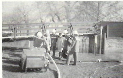
Wasserentnahme von der Altmühl.
