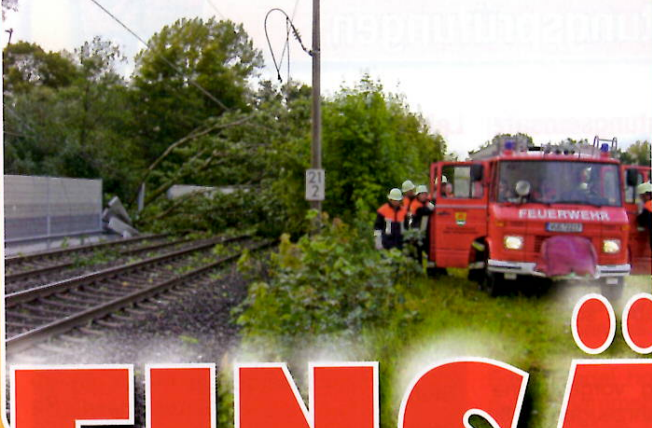
Sturmschaden in Unterwürmbach.
